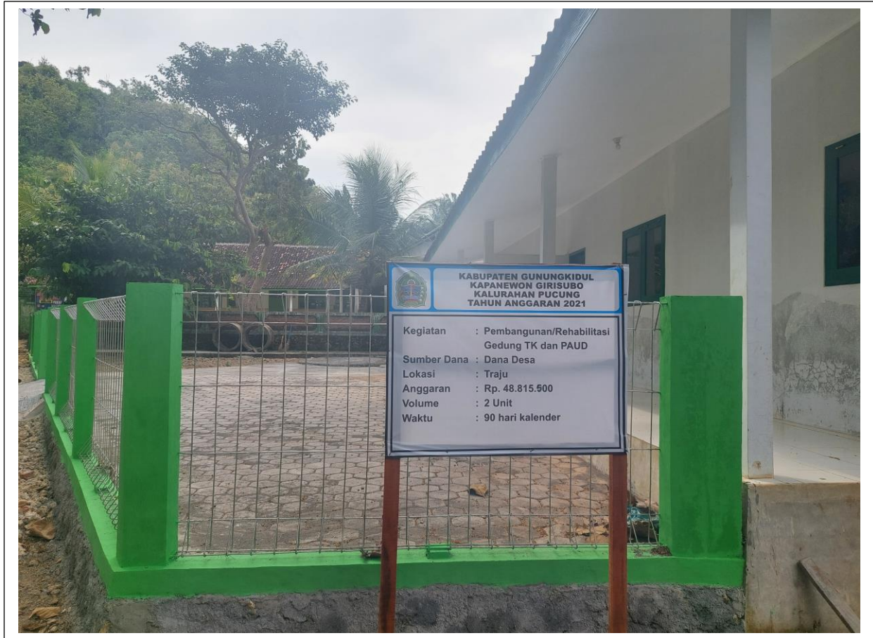
Gambar : Papan Proyek Pembangunan gedung PAUD/TK
